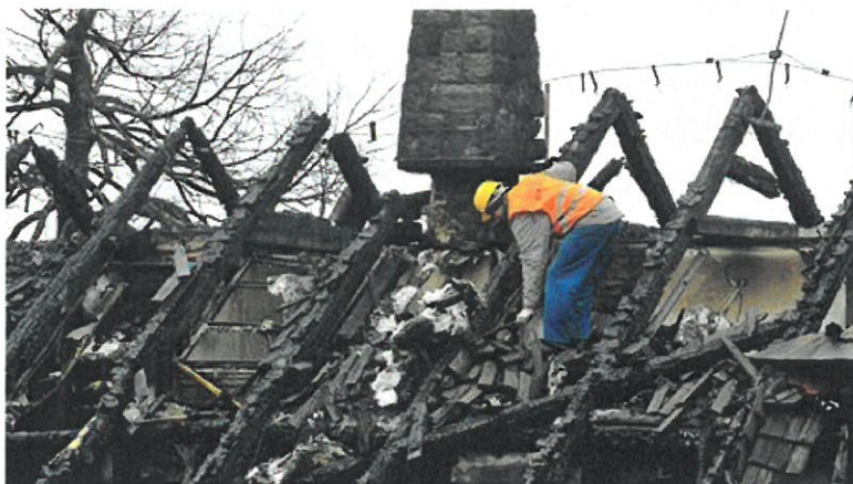
Požiar strechy spôsobený komínovým telesom
